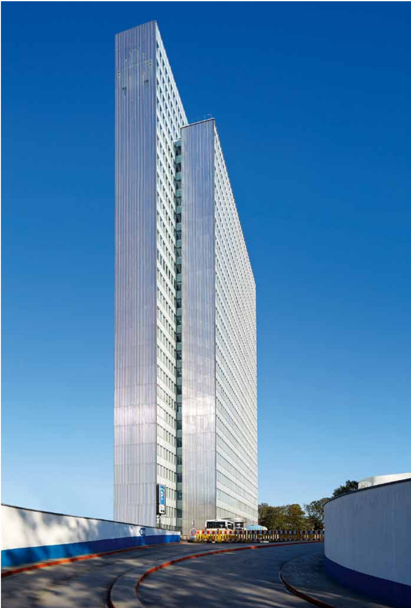
Die äußere Erscheinung des Hochhauses hat sich kaum verändert. Die Edelstahl-Verkleidung der Schmalseiten blieb sogar erhalten. Foto: Ralph Richter
