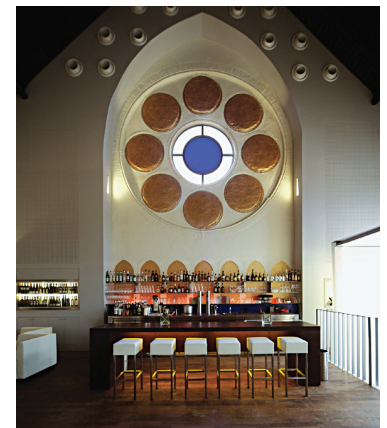
Eine reversibel eingebaute Vorwand verbirgt technische Installationen. Unter 10 ↑ dem Giebel blasen Hochgeschwindigkeitsdüsen Frischluft in den Raum.
