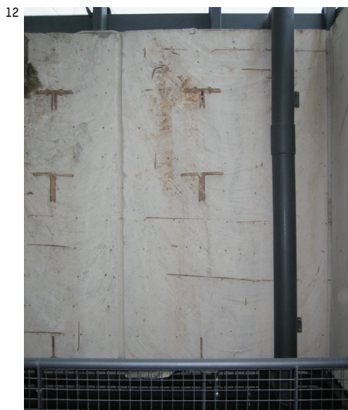
12 ↑ Die neue Öffnung im Bunkerdach enthüllt an den Schnittflächen die alte Konstruktion: Fachwerkträger aus Stahl, die in der gewaltigen Betonmasse verschwanden. Die senkrechte Kernbohrung und die kreisförmigen Sägelinien bleiben als Spuren des Aufschneidevorgangs sichtbar. Mit einem Diamantkabel ließen die Architekten das 13 → Betondach aufsagen.
