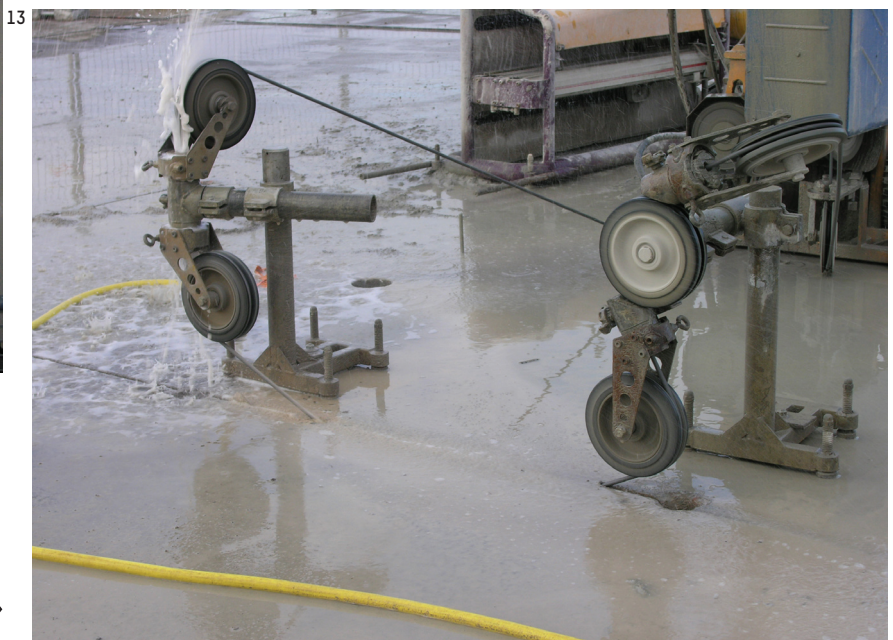
12 ↑ Die neue Öffnung im Bunkerdach enthüllt an den Schnittflächen die alte Konstruktion: Fachwerkträger aus Stahl, die in der gewaltigen Betonmasse verschwanden. Die senkrechte Kernbohrung und die kreisförmigen Sägelinien bleiben als Spuren des Aufschneidevorgangs sichtbar. Mit einem Diamantkabel ließen die Architekten das 13 → Betondach aufsagen.
