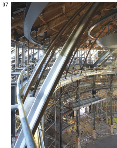
↑ 07, 08 Die neue Stahlkonstruktion war nur während der Bauzeit zu erkennen. Heute bleibt sie unsichtbar, da sie von innen mit den vorhandenen alten Holzelementen, von außen mit den alten Schieferplatten verkleidet ist.
